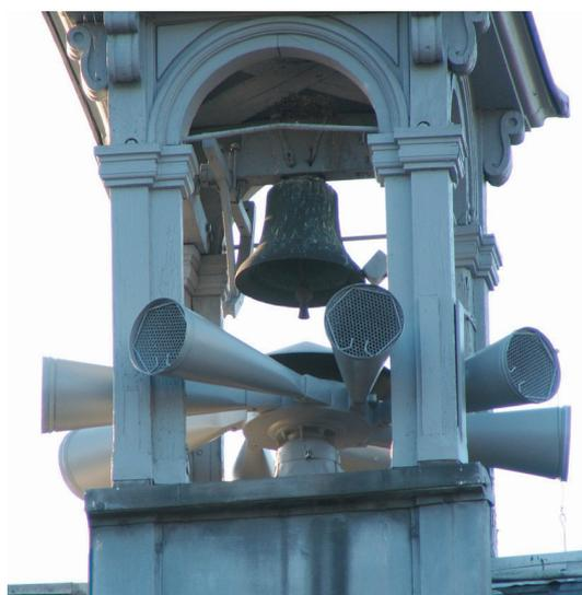
Dispositif d'alerte : les sirènes
